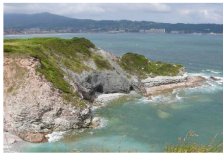
...ou totalement compressées et déstructurées.
